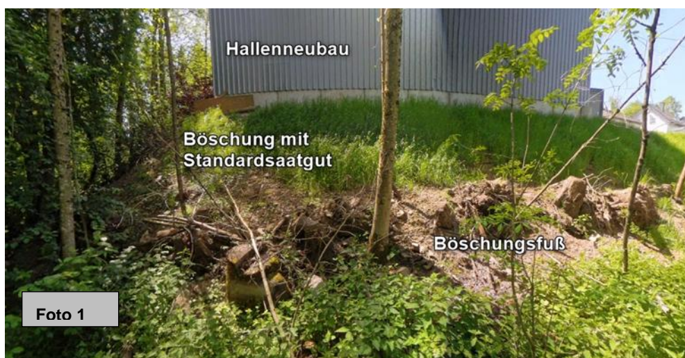
Abbildung 8: Hallenneubau von Nordosten aufgenommen (Foto Büro Ditter am 14.05.2025)
