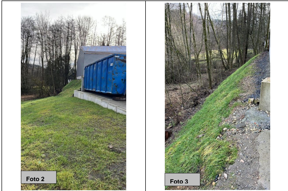
Abbildung 9: Böschungen im Norden (links) und Nordosten (rechts) der Halle mit umlaufendem Schotterstreifen (Aufnahme 30.1.2025, Quelle: Firma Hergenröder).
