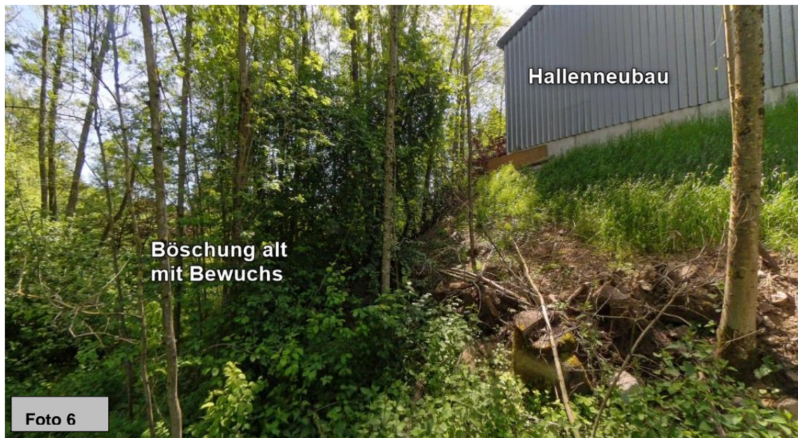
Abbildung 12: Hallenneubau mit Böschung im Osten und der alten bewachsenen Böschung (Foto Büro Ditter am 14.05.2025)
